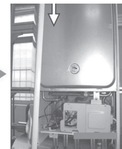
5. Поставить крышку на боковую поверхность (нет необходимости отключать от сигнальной линии)
